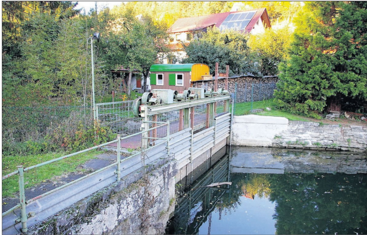
Die Brücke gehört Wasserkraftbetreiber Eberhard Oehler. Der Fußweg diesseits und jenseits davon liegt auf städtischem Grund. Gleich nebenan sind der Fischinger Kindergarten und die Grundschule, doch nicht nur Schüler nutzen den eisernen Steg als beliebte Abkürzung Richtung Wohngebiet.
