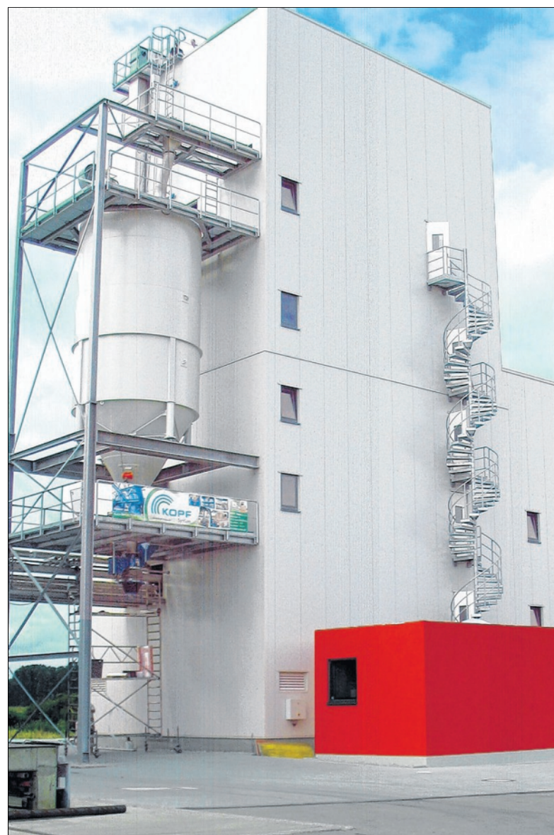
Im Klärwerk Mannheim wird Energie aus Klärschlamm erzeugt, in einer Vergasungsanlage der Firma Kopf aus Bergfelden. Privatbild
