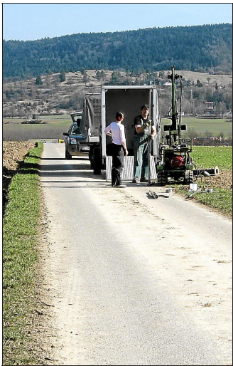
Um festzustellen, ob das Gelände für Teststrecken geeignet ist, hat die Daimler AG Bohrungen in Auftrag gegeben.
