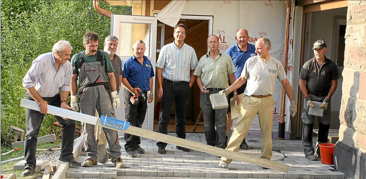
Der Rohbau steht, jetzt wird gepflastert. Das Bild zeigt die freiwilligen Helfer mit Pfarrer Oliver Velm (Mitte) und Ortsvorsteher Erwin Stocker (vierter von rechts). Foto: Steinmetz
